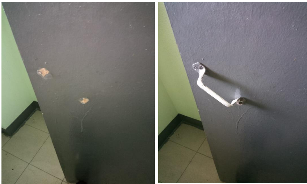
4) 28.11.23 Этаж 20 - Установка ручки.
