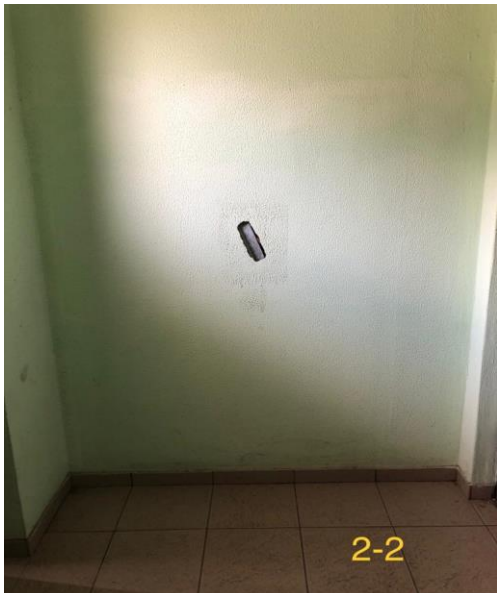
10) 02.11.23 Этаж 2 - Ппробита стена в тамбуре от ручки двери.
