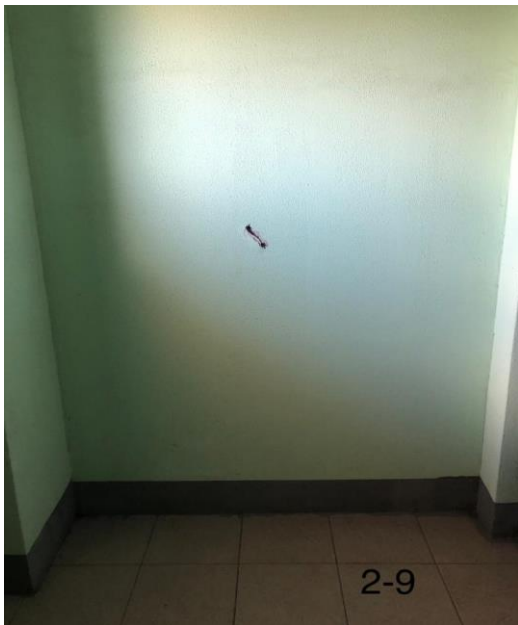
10) 02.11.23 Этаж 2 - Ппробита стена в тамбуре от ручки двери.
