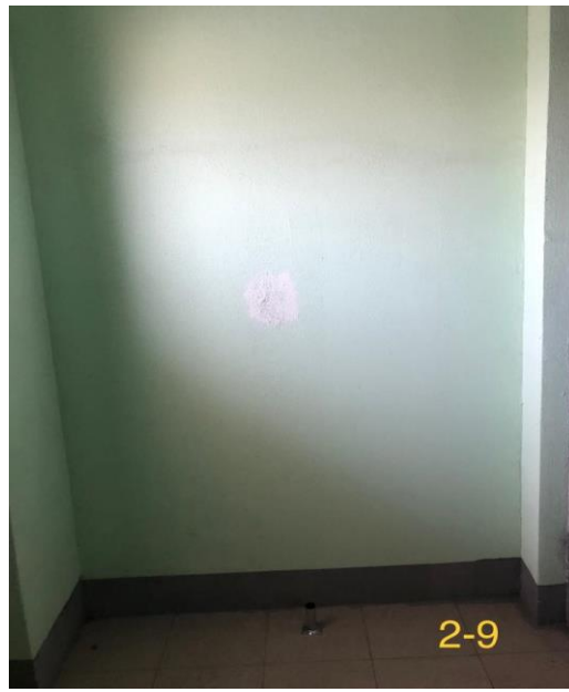
10) 02.11.23 Этаж 2 - Ппробита стена в тамбуре от ручки двери.
