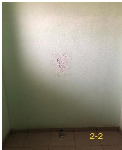
10) 02.11.23 Этаж 2 - Ппробита стена в тамбуре от ручки двери.
